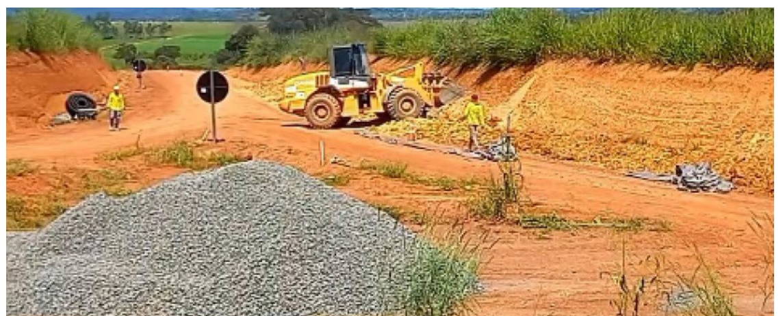
Obras em estradas e rodovias que servem Doverlândia — Foto: Comunicação/Prefeitura Municipal.
